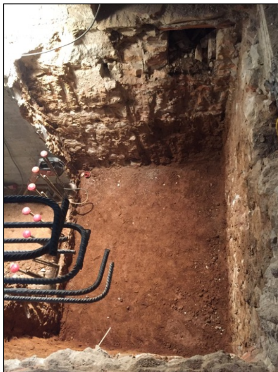
Fotografia 11. Vista de les argiles UE102.
