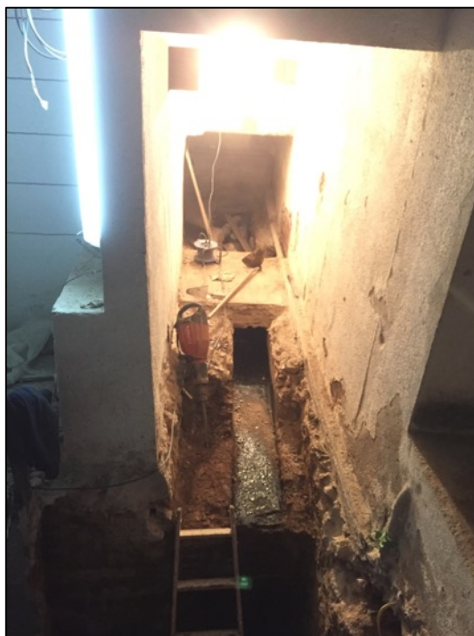
Fotografia 5. Claveguera UE104 en la zona de sota l'escala existent.
