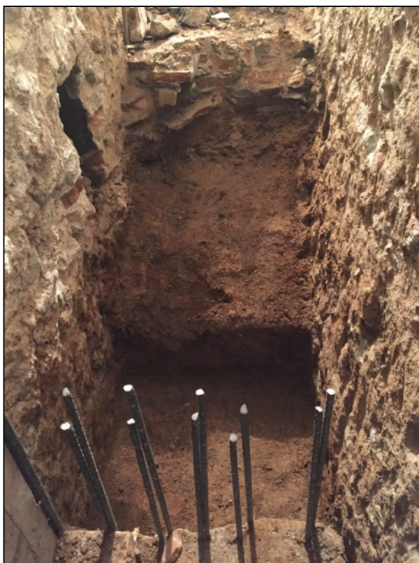
Fotografia 14. Detall ariles UE102 rebaixades en pendent per fer plataforma nova escala.
